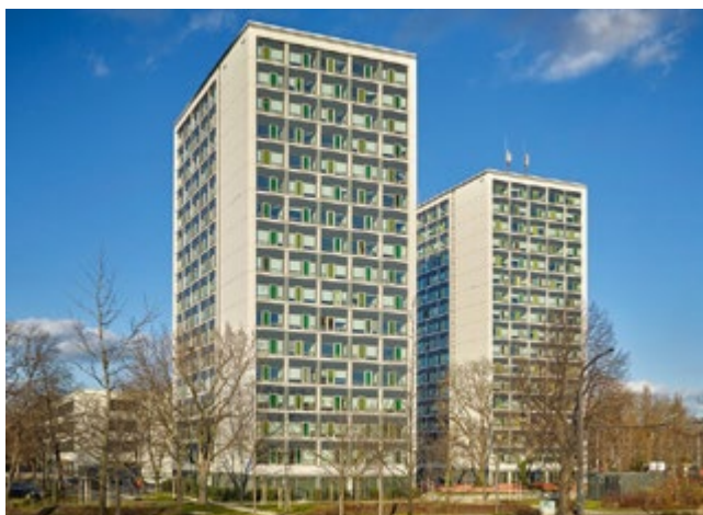
Hochhäuser Gret-Palucca-Straße 9 und 11, Dresden
