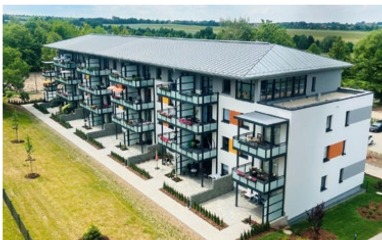
Sanierung Neuplanitzer Straße, Zwickau
