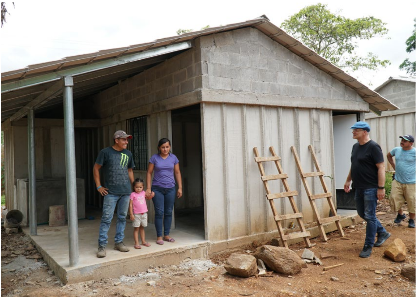
Die junge Familie Tejada freut sich über ihr neues Zuhause! Der Vater hat bei den Bauarbeiten fleißig mitgearbeitet.
